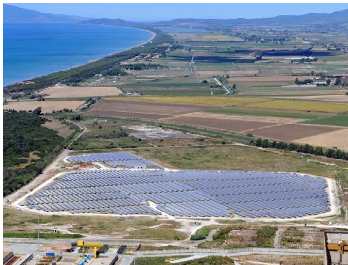
Abbildung 13: Solarpark Montalto di Castro, Italien, 84,2 MWp 24
