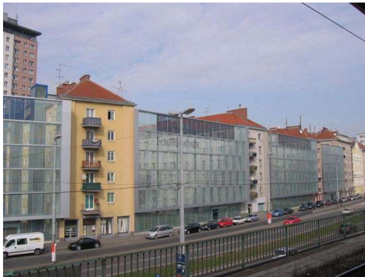
Abbildung 9: Lärmschutzwand in Wien, 18 m hohe Lärmschutzwand mit integrierter Photovoltaik, Module: 54 Verbundsicherheitsglas-Module (1.230 x 2.904 mm), Installierte Fläche: 188 m 2 , Installierte Leistung: 15,4 kWp 19
