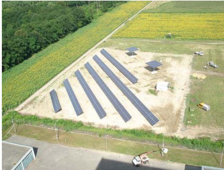
Abbildung 18: Photovoltaik-Anlage Zwentendorf, NÖ, 180 kWp, Aufdachanlage, Fassadenanlage und Freiflächen-Solarpark. Auf Freiflächenanlage gibt es neben fix aufgeständerten Solargeneratoren, auch der Sonne nachgeführte Solarsysteme. Das Gelände des Atomkraftwerkes ist nach wie vor ein zugelassener Kraftwerksstandort, daher mussten keine aufwändigen Bewilligungen mehr eingeholt werden. Auch die bereits vorhandene Infrastruktur ist von Vorteil, denn in Zwentendorf sind bereits wichtige Anlagenteile vorhanden, um Energie ins Stromnetz einzuspeisen. 28
